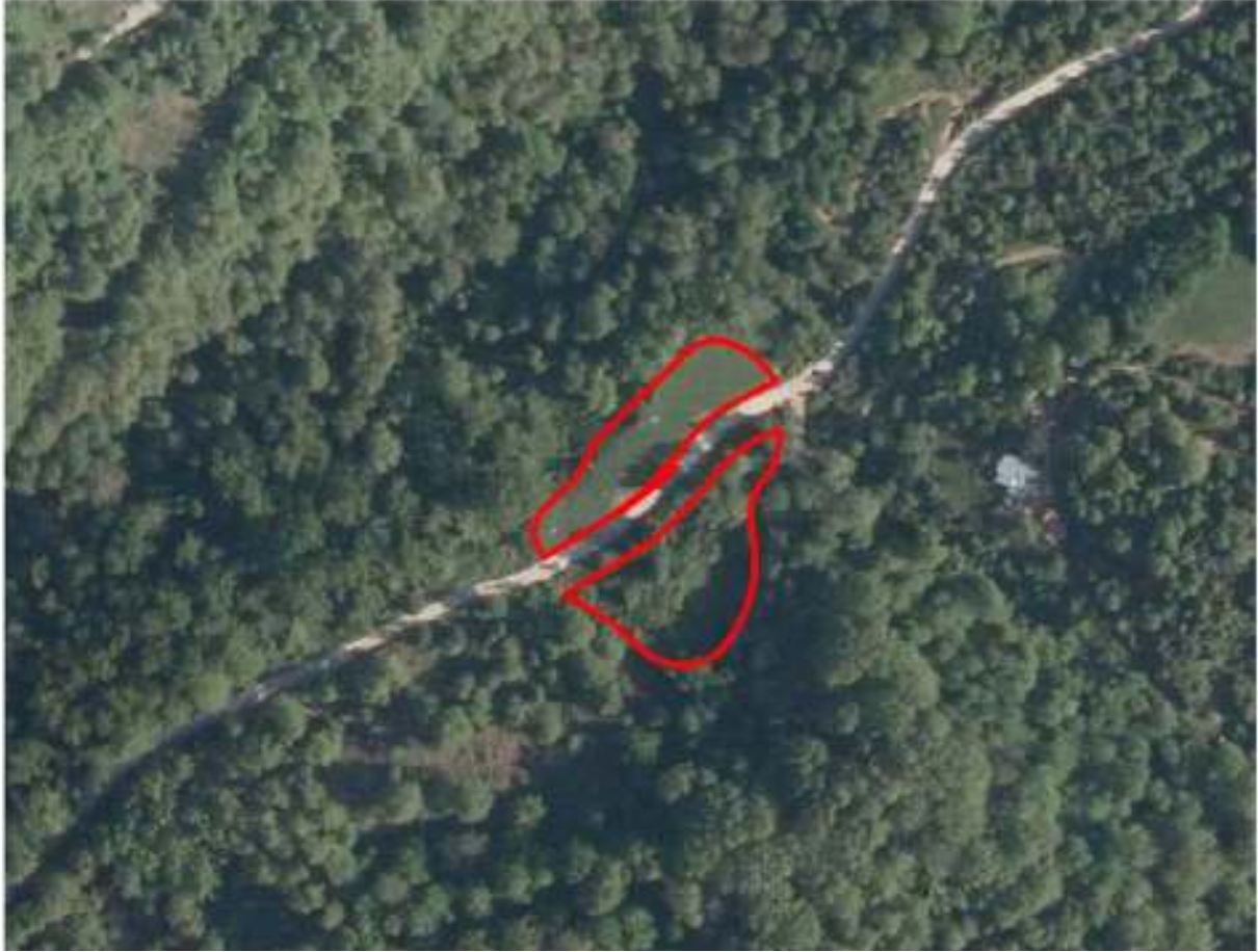
Foto 5: Stato dei luoghi risalente al 2012
